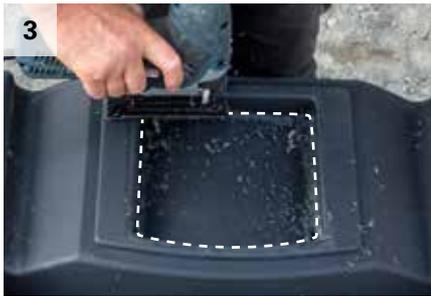
Die Seiten der Tunnelöffnung sind mit einem geeigneten Schneidewerkzeug zu öffnen.
