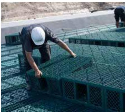
Entsprechend der Planung sind die Rigofill inspect Blöcke auf dem Planum auszulegen. Sie sind so aneinanderzureihen, dass sich die geplanten Rigolentunnel ergeben. Der Einbau bei Frost erfordert grundsätzlich höhere Sorgfalt (Schlagempfindlichkeit, siehe Hinweise im Abschnitt Transport und Lagerung).
