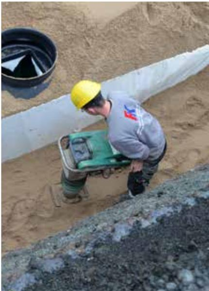
Die Blockverbinder arretieren die einzelnen Rigofill inspect Blöcke und verhindern weitgehend ein seitliches Verrutschen des Rigolenkörpers beim Hinterfüllen.
