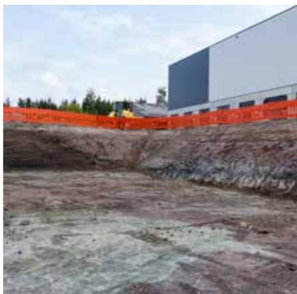
Die Baugrube ist gemäß Planungsvorgaben herzustellen. Bei den Aushubarbeiten sind die Baugrubenwände so abzuböschen oder zu verbauen, dass Beschäftigte nicht durch das Abrutschen von Massen gefährdet werden können. Zusätzlich sind nationale Vorschriften zu beachten. Es sind Maßnahmen zu treffen, dass die Baugrube während der gesamten Ausführungszeit frei von Wasser ist.
