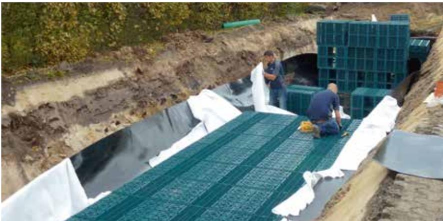
Für den Einsatz von Rigofill inspect zur Regenwasserspeicherung kann die Anlage mit einer Kunststoff-Dichtungsbahn (KDB) ummantelt werden. Neben dieser Einbauanleitung sind zudem die Vorgaben des Herstellers der Kunststoff-Dichtungsbahn (KDB) zu deren Einbau zu beachten.
