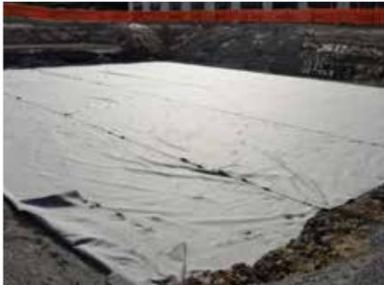
Die gesamte Rigole ist mit RigoFlor-Rigolenvlies zu umhüllen. Vor der Verlegung der Blöcke ist das Vlies auf dem Planum auszulegen. Das Vlies muss seitlich genügend Überstand haben, damit anschließend die gesamte Anlage umhüllt werden kann.
