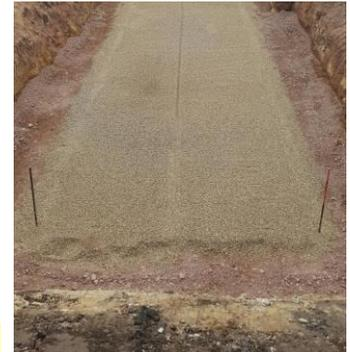
**HINWEIS:** Die Güte der Auflagerfläche ist maßgeblich für die Verlegung und hat wesentlichen Einfluss auf das Trag- und Setzungsverhalten der RigoCollect Anlage.
